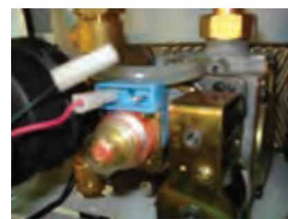
نحوه تست شیربرقی گاز: شیلنگ گاز پکیج را از قسمتی که به لوله گاز خانه متصل شده باز می کنیم و در زمان جرقه زنی پکیج اگر با فوت کردن درون شیلنگ گاز مسیر فوت باز باشد شیربرقی گاز سالم و گرنه معیوب است. البته بایستی با اهم متر برق ورودی به شیربرقی گاز را در زمان جرقه زنی بررسی گردد در صورت معیوب بودن شیربرقی گاز پکیج تا مرحله جرقه زنی پیش می رود اما شعله تشکیل نمی گردد.
