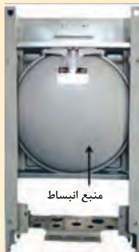
**نحوه تست مخزن انبساط:** فشار هوای داخل منبع انبساط در زمانی که آب در مدار گرمایی نباشد، بایستی بین ۰/۶ تا ۰/۲ بار باشد بنابراین برای تست سالم بودن مخزن انبساط بایستی آب مدار گرمایی را تخلیه کرد و با فشارسنج میزان هوای منبع انبساط را اندازه‌گیری نمود.
