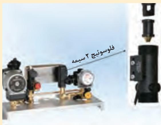
اتصالات الکتریکی فلوسوئیچ را قطع نمایید. مهره‌ای که مربوط به اتصال فلوسوئیچ به لوله آب سرد ورودی به مبدل ثانویه می‌باشد را باز نمایید. گیره که باعث اتصال لوله سرد ورودی به چند راهه آب می‌گردد را باز نمایید. مهره که لوله پرکن را به فلوسوئیچ محکم کرده شل کنید. مهره که مربوط به اتصال فلوسوئیچ می‌باشد را باز نمایید. فلوسوئیچ را از محل خودش بیرون آورید.
